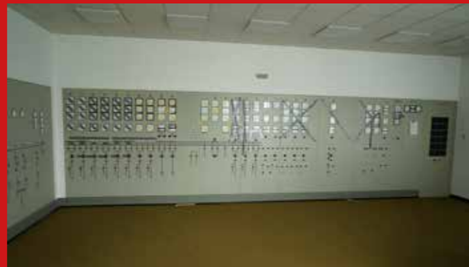
Die alte Schaltzentrale und der Nebenraum sind für den Ausbau als großer Schulungsraum vorgesehen.
